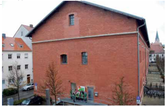
Leuchtender Backstein ummantelt das Gebäude des ehemaligen königlich-bayerischen Proviantamt. Der Zufall will es, dass seit wenigen Monaten nun die Helfer der Tafel zur Versorgung bedürftiger Ingolstädter beitragen.
